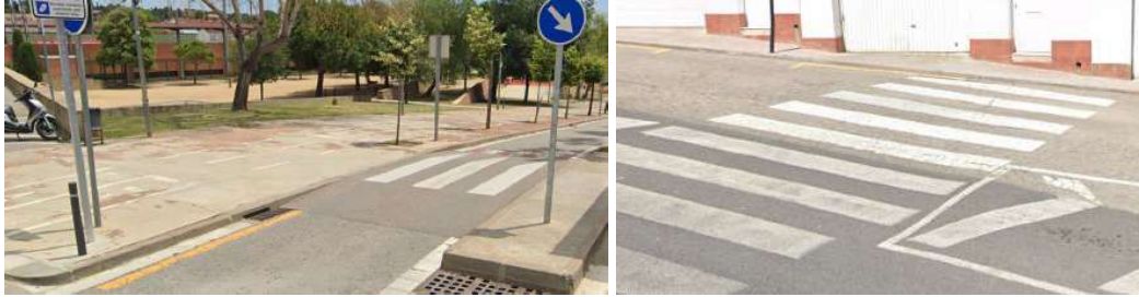
Exemple de passos de vianants, un elevat i l'altre amb el gual sense accessibilitat
